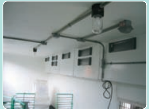
W400 の設置状況
